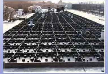
屋上でも植栽することができます。
